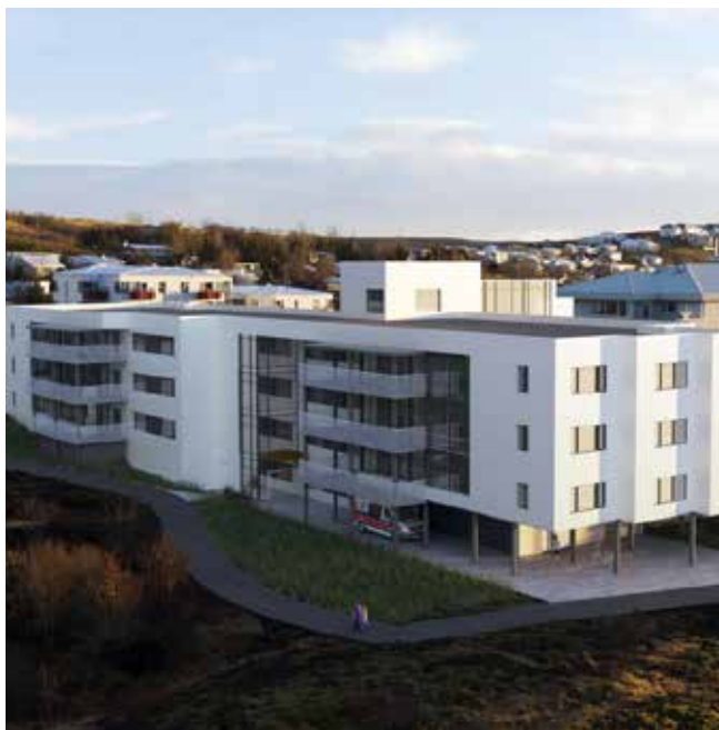
Nýbygging Sólvangs í Hafnarfirði
